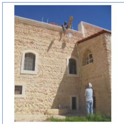
De dakpannen worden met een katrol naar boven getrokken. De allergrootste, meest prachtige bouwwerken uit de geschiedenis werden ook zonder elektriciteit gebouwd!
