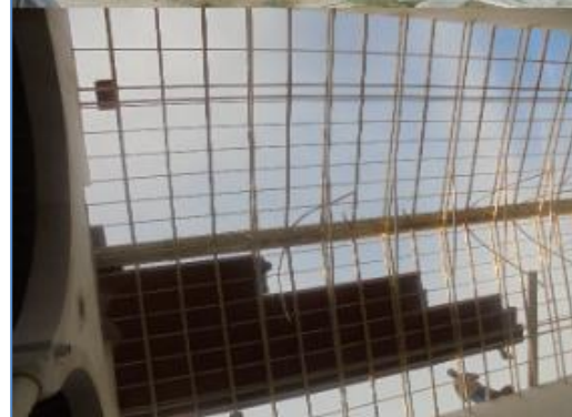
Het dak van de "Cour St. Jacques" wordt gedeeltelijk met dakpannen en gedeeltelijk met plexiglas bedekt.
