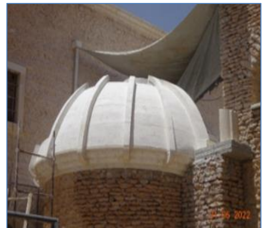
Steenhouwer werkt de koepel af van de kapel van het metokion (St. Jozefsklooster).
