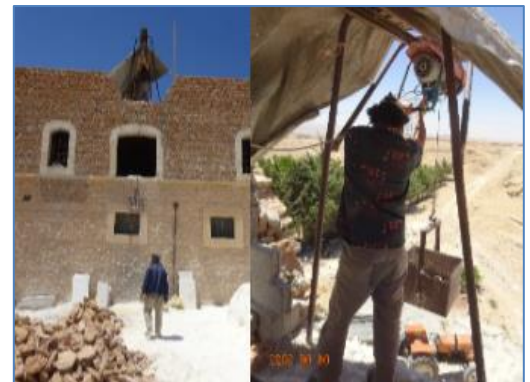
Stenen naar boven brengen met een katrol.
