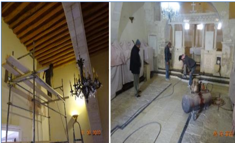
Werkzaamheden in de Kerk.
