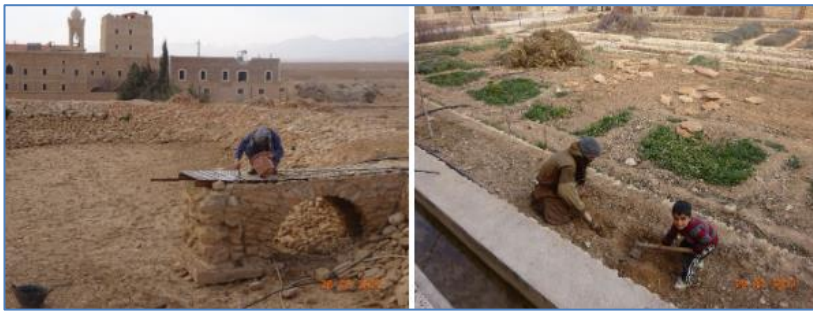
De houten brug van de visvijver krijgt een olielaag, en rondom de kleine binnentuin worden granaatappelbomen geplant.
