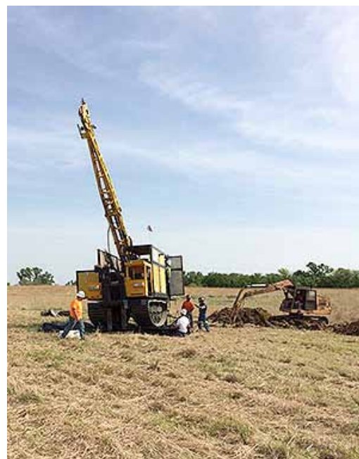
Drilboor op het bedrijfsterrein van Elk Creek.
